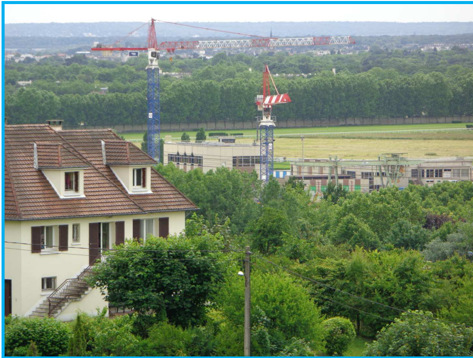
Figure 34 : Exemple de vue plongeante sur le chantier du prétraitement
