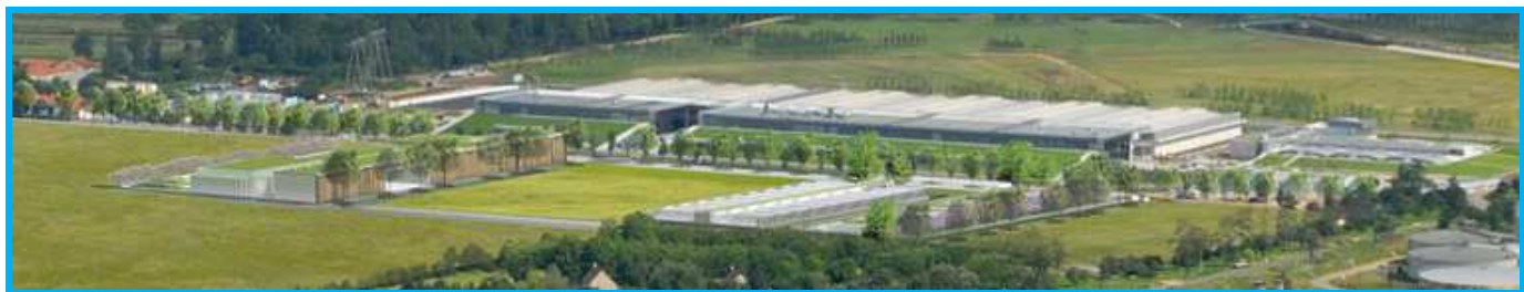
Figure 43 : Vue des unités de traitement des jus et dénitrification complémentaire.
