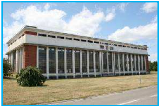
Figure 36 : Salle des machines
