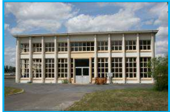
Figure 35 : Bâtiment d'exploitation relèvement
